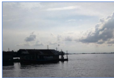
Gambar 9. Rumah Lanting/Rumah Terapung ( Raft Houses ) di Kampung Apung Pulau Bromo, Mantuil. Sumber: Dokumentasi Lapangan, 2019
