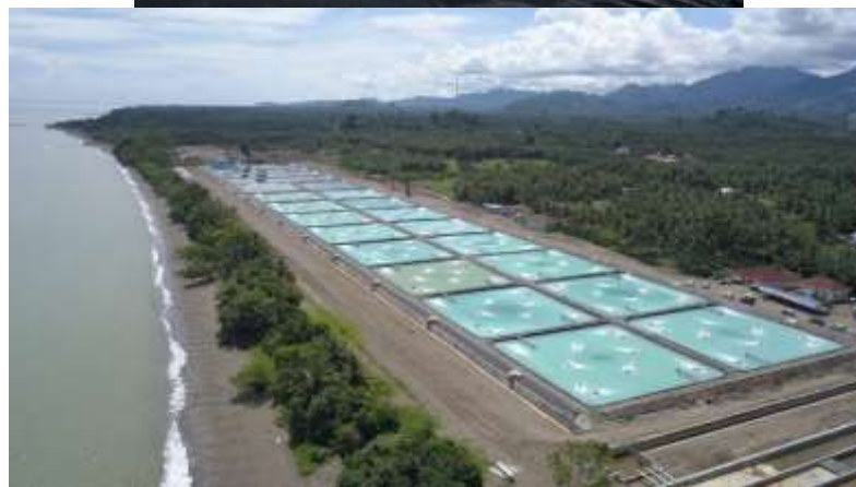
Gambar 5.32. Contoh konstruksi kolam/tambak persegi menggunakan terpal dan kincir untuk tambak intensif
