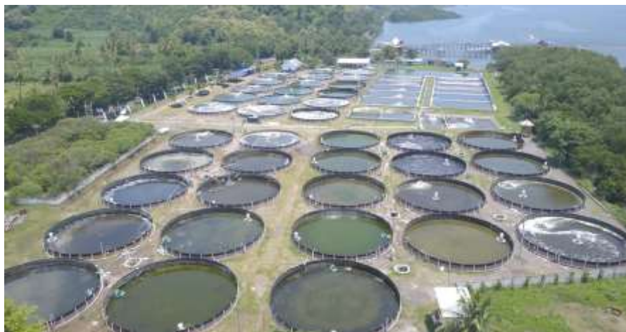
Gambar 5.30. Contoh konstruksi kolam/tambak bundar sistem bioflok
