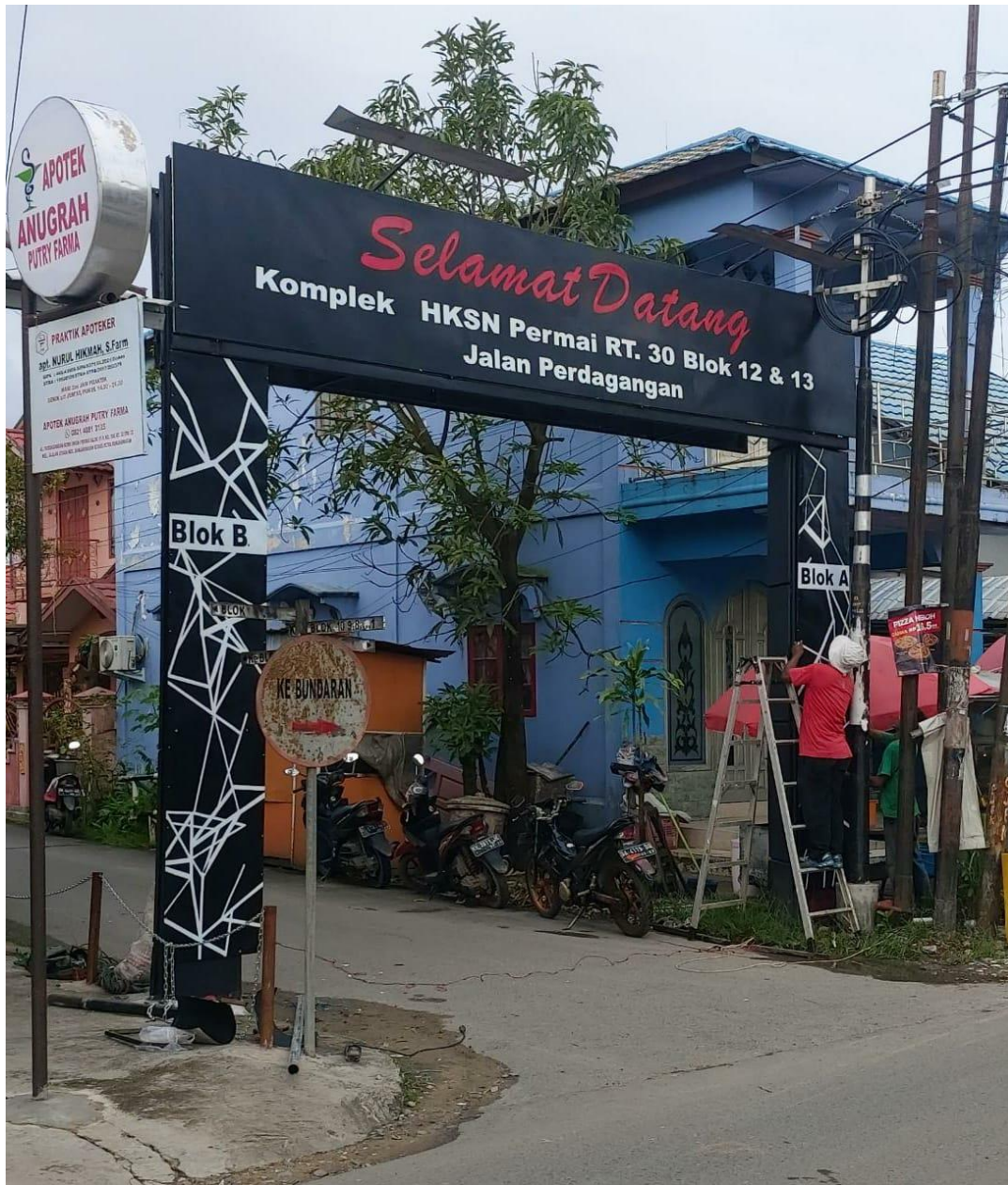
Pintu Gerbang Komplek HKS Selesai Dikerjakan
