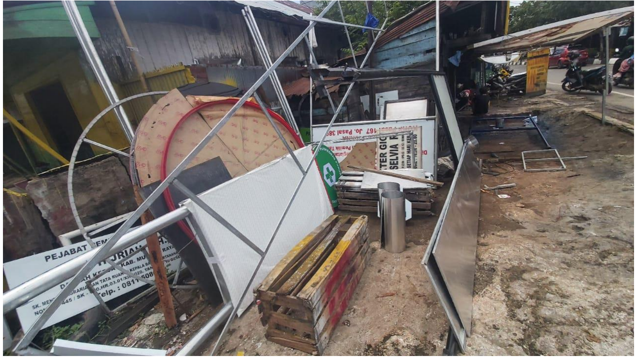
Bahan Pintu Gerbang Siap Dikerjakan
