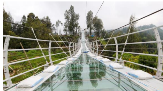
Gambar 6. Pembebanan karung pada Uji beban statis Jembatan Kaca Bromo
