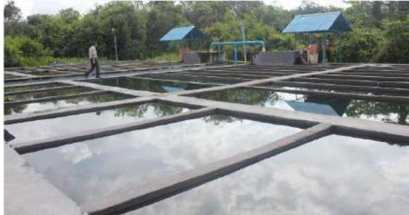
Gambar 54. Filtrasi pada SPAM IKK Kab. Bengkalis, Riau
