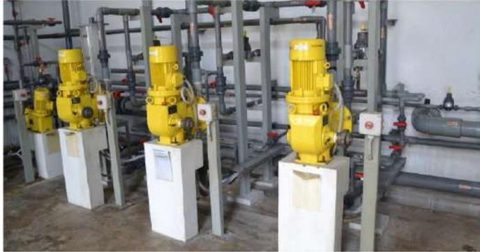
Gambar 56. Pompa dosing pada IPA Kab. Tangerang, Banten
