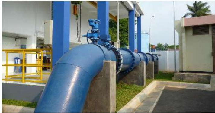
Gambar 48. Air valve pada IPA Kab. Tangerang, Banten
