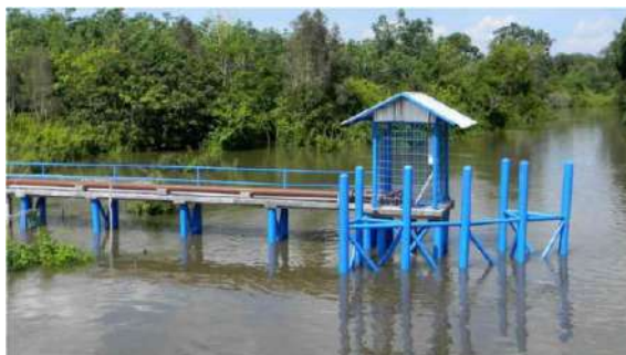
Gambar 4. Intake pada SPAM IKK Kab. Bangka Tengah, Bangka Belitung
