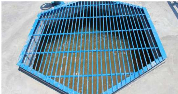
Gambar 9. Bak flokulasi SPAM IKK Kab. Gianyar, Bali (Sumber : Prasarana dan Sarana Air Minum, 2015)
