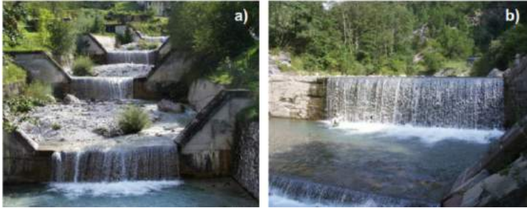
Gambar 6-9 Check Dam di Italia dibuat secara a) berundak dan b) tunggal
