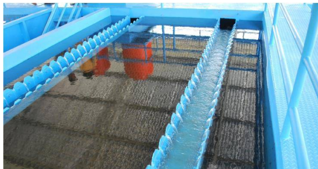
Gambar 53. Bak sedimentasi pada SPAM IKK Kab. Madiun, Jawa Timur
