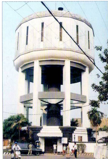
Gambar 21. Menara air kapasitas 750 m 3 di Manado
