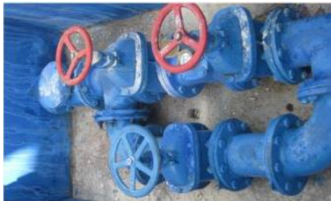
Gambar 62. Box valve pada SPAM IKK Kab. Biak Timur, Papua
