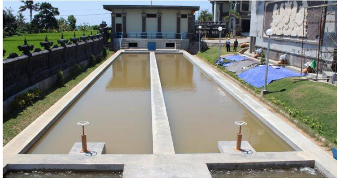
Gambar 50. Bak prasedimentasi pada SPAM Regional Kabupaten Gianyar, Bali
