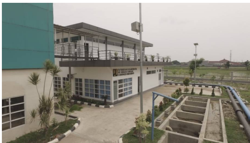
Gambar 26. SPAM IKK Sindang Pasekan Kab. Indramayu
