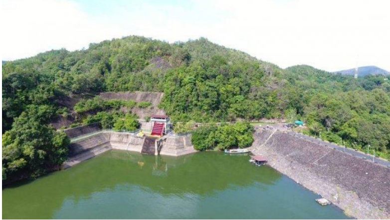
Gambar 1 Bendungan di Riam Kanan memiliki dinding bendungan tebal di bagian bawah (Dinayanti, 2020)
