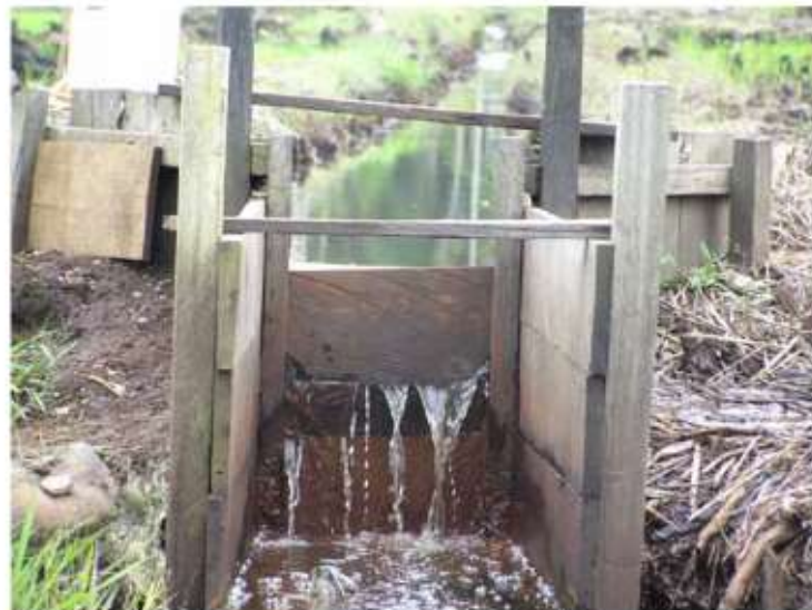
Gambar 2.10 Pintu air tradisional untuk mengatur tinggi muka air (Agus & Subiksa, 2008)
