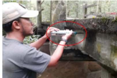
Gambar 4 Dokumentasi Pengambilan Data Mutu Beton Aktual
