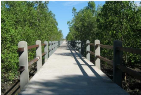
Gambar 2 Dokumentasi Hasil Pekerjaan Jembatan KKMB (CV. Mitra Jasa Binapratama, 2011)
