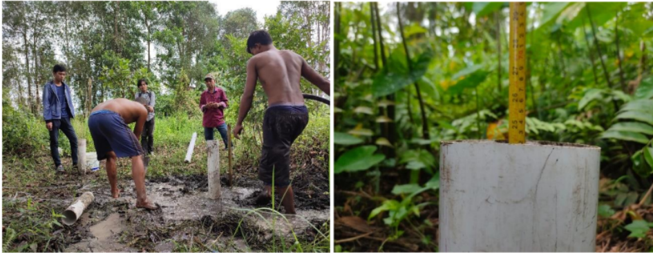
Gambar 3. Pemasangan alat dan pembacaan elevasi muka air tanah
