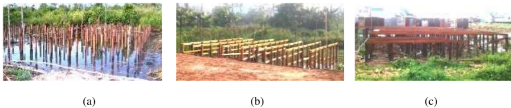
Gambar 9 . Deretan Tiang Kayu
