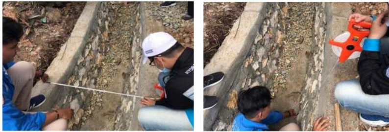
Gambar 9. Drainase yang baru di bangun di kiri dan kanan jalan
