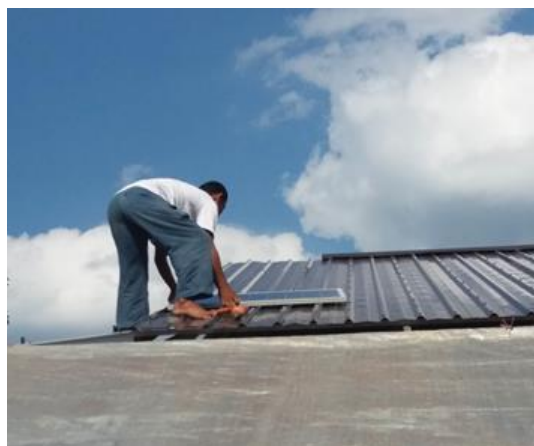
Gambar 5 Pemasangan Panel Surya
