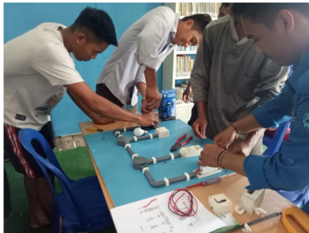
Gambar 7. Pemasangan Pipa Instalasi
