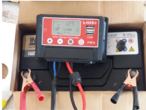
Gambar 6 Pengukuran Tegangan Pada Controller
