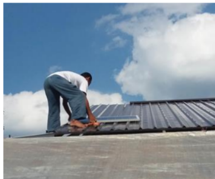
Gambar 5 Pemasangan Panel Surya
