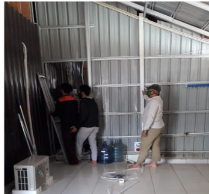
Gambar 5. Kondisi bangunan yang rentan terjadinya hubung singkat
