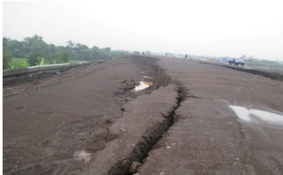
Gambar 10. Kelongsoran badan jalan pada area lainnya. (Mochtar, 2014)
