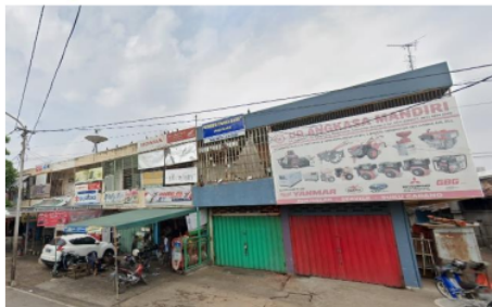
Gambar 6. Lokasi Site dan Bangunan Eksisting Sumber: Penulis
