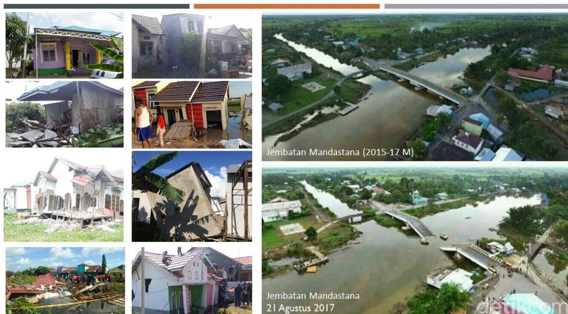
Gambar 1. Permasalahan Konstruksi Bangunan di Lahan Basah
