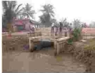
*O&P saluran sangatlah penting untuk mengatur aliran air. Nampak di gambar, saluran sebelum dan sesudah dilakukan O&P, perbaikan saluran sekunder setelah selesai, Pengoperasian saluran sekunder ini masuk dalam lingkup kegiatan monitoring proyek percontohan.*
