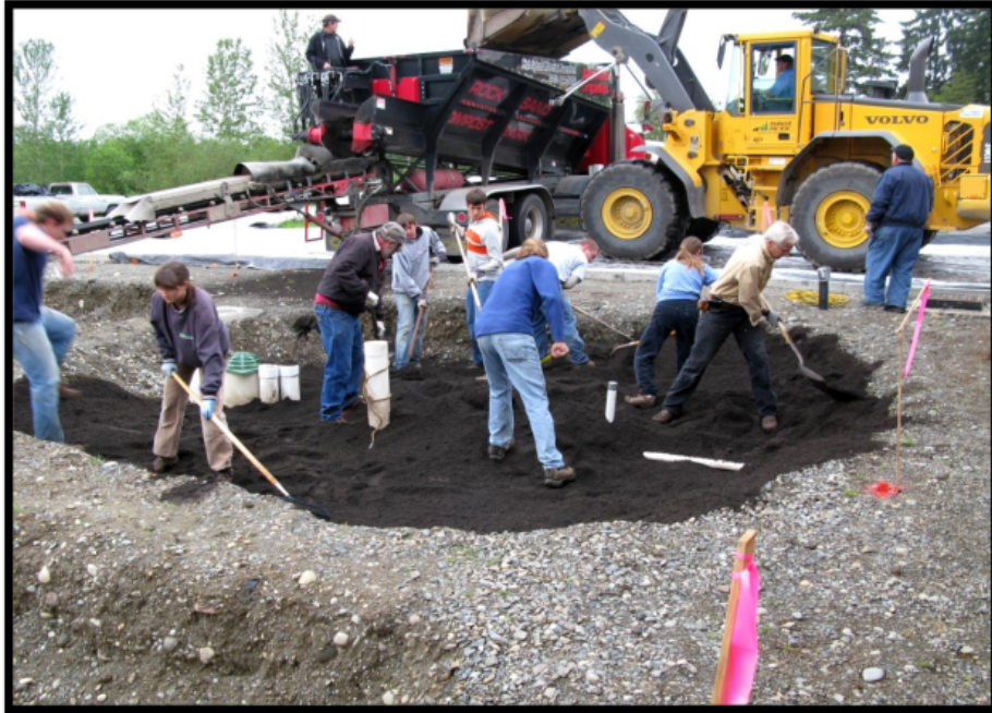
Gambar 3. 7. Menggali dan Mengganti Tanah Asli dengan Tanah Campuran
