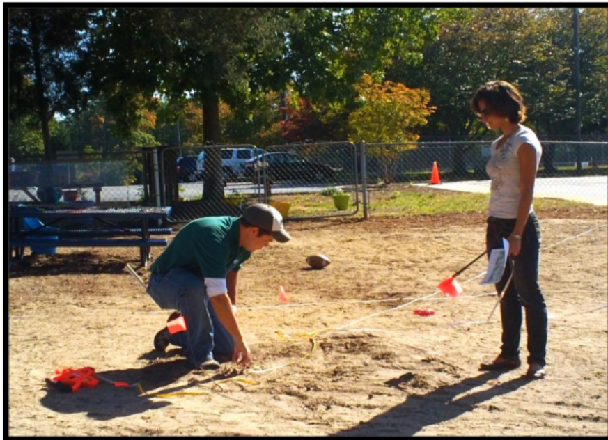
Gambar 3. 2. Membuat Layout Rain Garden
