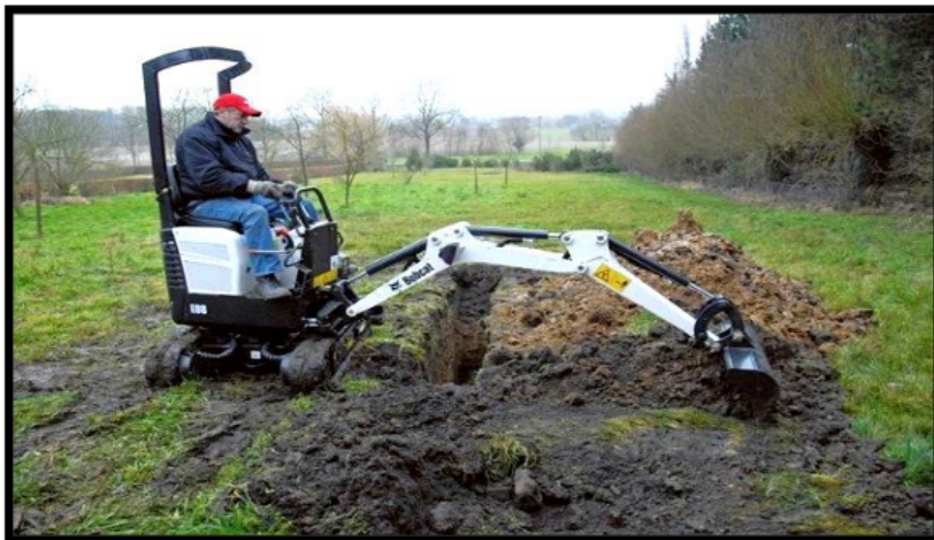
Gambar 3. 4. Kegiatan Menggali dengan Mini Excavator Sumber: http://img.directindustry.com/images_di/photo-g/mini-crawler-excavators-31379-2360295.jpg
