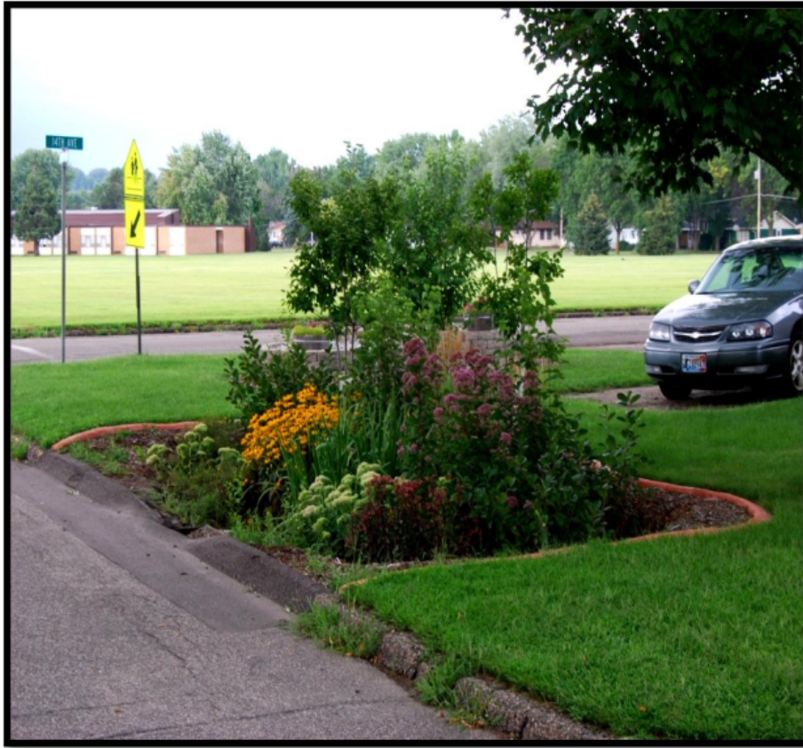
Gambar 3. 11. Rain Garden Pada Sisi Jalan
