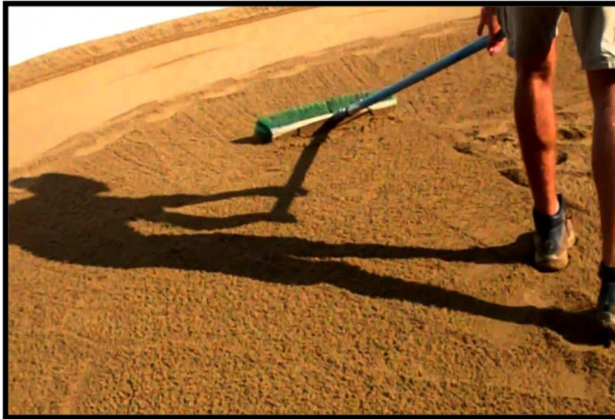
Gambar 3. 6. Membuat Lantai Rain Garden yang Datar Sumber: http://i1.ytimg.com/vi/u7fyleus9gi/maxresdefault.jpg
