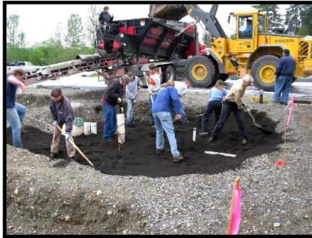
Gambar 5. Menggali dan Mengganti Tanah Asli dengan Tanah Campuran ( http://www.wastormwatercenter.org/files/gallery/MvLmViVduzQe5pPM.jpg ).
