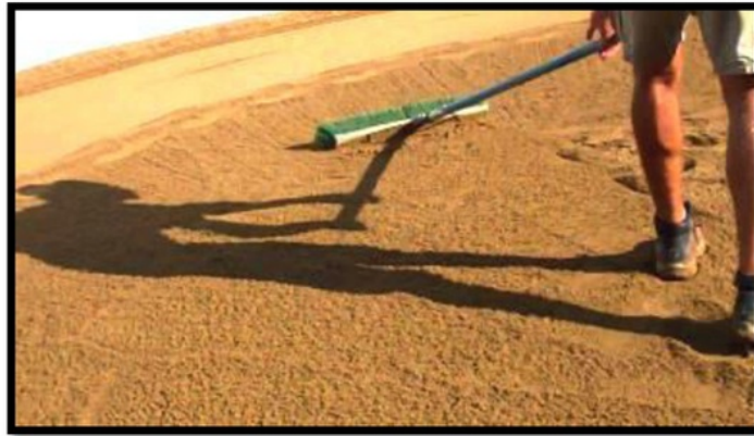
Gambar 4. Membuat Lantai Rain Garden yang Datar ( http://i1.ytimg.com/vi/u7fyLEUS9gI/maxresdefault.jpg ).
