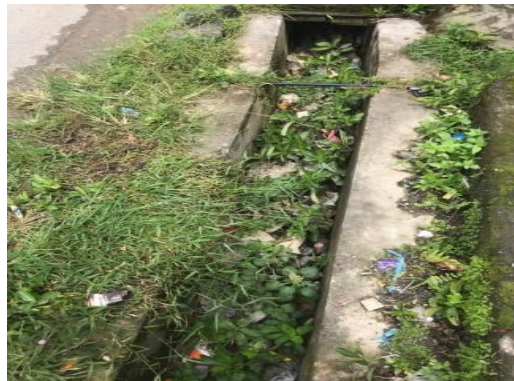
Gambar 3. 1 Kondisi Eksisting Saluran Drainase
