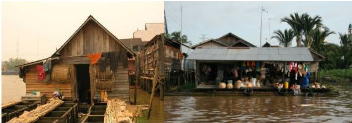
Gbr 3. Rumah Lanting di Banjarmasin Sumber ; Peneliti, 2008
