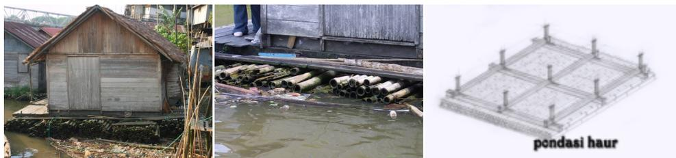
Gambar 6. Material pondasi dari bambu (haur)
