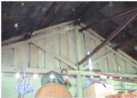
Gambar 7. Konstruksi Atap Pelana
