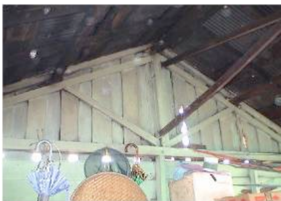
Gambar 7. Konstruksi Atap Pelana
