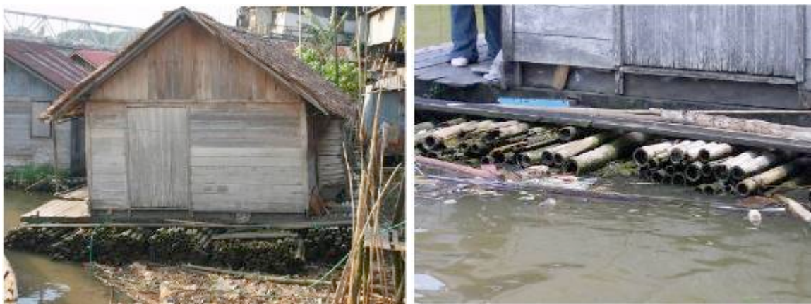
Gambar. 4. Material Pondasi dari Bambu.
