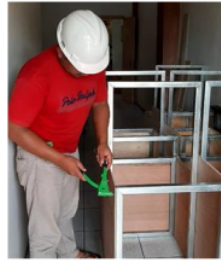
Proses konstruksi rangka
