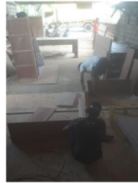
Proses pembuatan dinding
