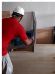
Proses pemasangan wastafel
