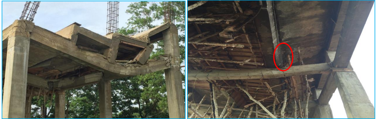
Gambar 1. Struktur balok dan pelat lantai beton lantai-1
