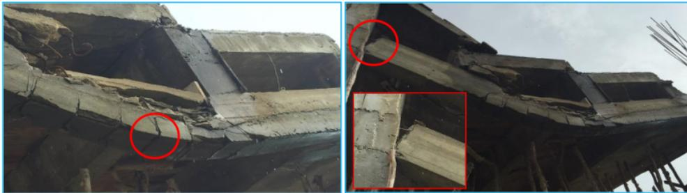
Gambar 2. a. Selimut beton balok beton lantai 1 tidak ada, b. Jumlah tulangan tumpuan balok bagian atas terlihat hanya 2 bh.
