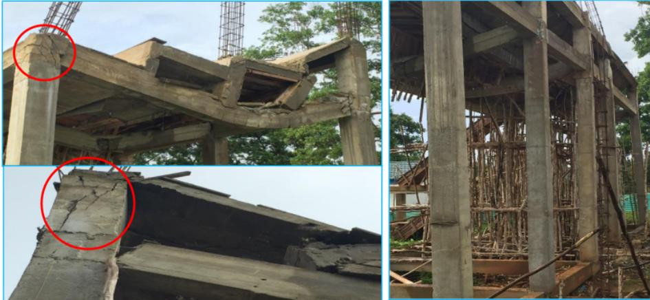
Gambar 4. a. Struktur Kolom Beton bagian atas retak dan remuk, b. Struktur Kolom Beton bagian tengah dan bawah masih baik tidak mengalami retak
