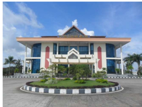
Gambar 1 Kondisi Eksisting Gedung Putri Karang Melenu Tenggarong.
