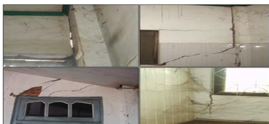
Gambar 10. Dinding bata bagian pinggir mengalami kemiringan, dan dinding bata pada tingkat-2 yang masih baik
