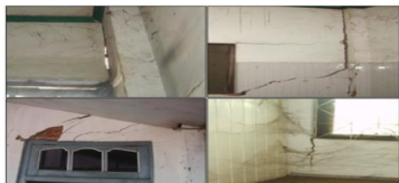
Gambar 10. Dinding bata bagian pinggir mengalami kemiringan, dan dinding bata pada tingkat-2 yang masih baik
