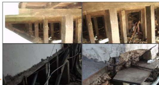
Gambar 6. Gambar kolom tingkat-2 yang masih baik
