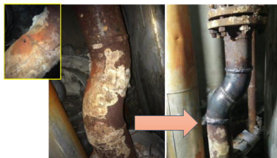
Gambar7. Penggantian Pipa Elbow
