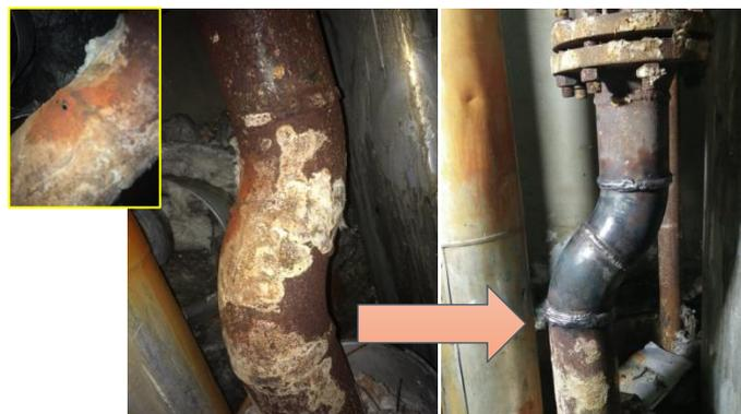
Gambar7. Penggantian Pipa Elbow
