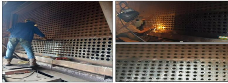
Gambar 9. Hasil Inspeksi/pengamatan Primary Air Heater (PAH)
