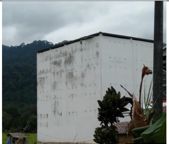
J6FQ+W2 Teluk Mesjid KM 24, Tlk. Mesjid, Kec. Pulau Laut Tim., Kab. Kotabaru, Kalimantan Selatan, Indonesia
