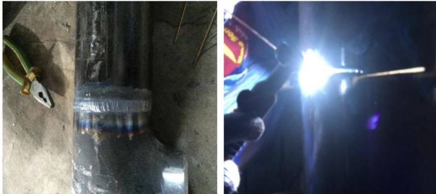
Gambar 12. Proses Pengelasan Menggunakan Las *TIG* pada Pipa *SAH*
