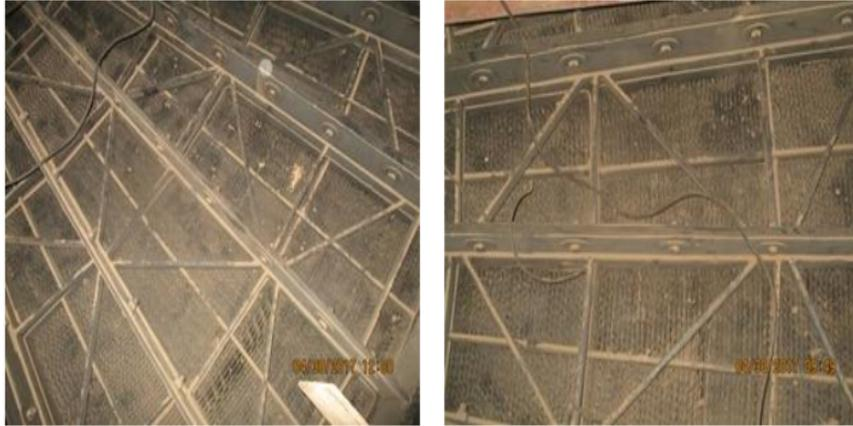
Gambar 10. *Slagging/ Kotoran di SAH*
