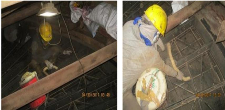
Gambar 11. Proses Pembersihan *Slagging/ Kotoran di SAH*
