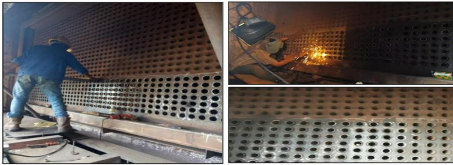
Gambar 9. Hasil Inspeksi/pengamatan Primary Air Heater (PAH)
