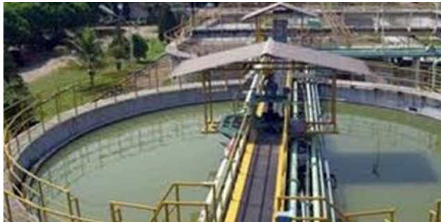
Gambar 19. Contoh IPAL perkotaan yang menggunakan aerator untuk memisahkan padatan dan cairan.
