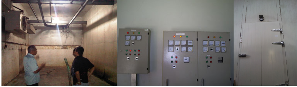
Gambar 5. Ruang Pelayuan dan Pembekuan dilengkapi dengan tenaga listrik untuk pendingin dan pintu kedap udara
