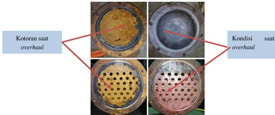
**Gambar 7:** Foto fouling Pada Saat Komisioning (Overhaul) Sebelumnya
