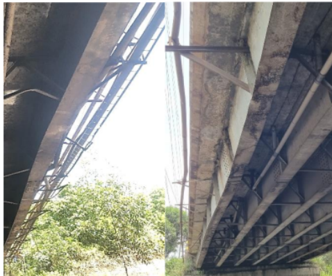
(a) (b) Gambar 3 Gelagar sisi luar jembatan
