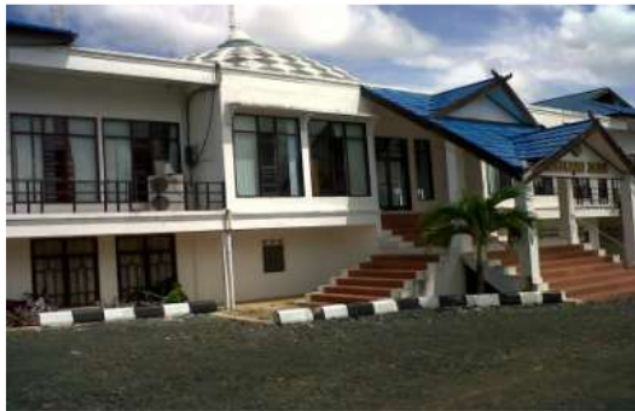
Gambar 1. Struktur Bangunan Gedung pendopo Iman
