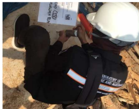
Gambar 5. Proses pengujian dilapangan dengan Schmidt Hammer Test
