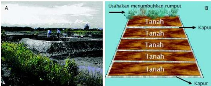
**Gambar 6.7** Kontruksi kolam dengan integrasi kapur pada pematang A = kontruksi kolam secara utuh dengan integrasi kapur, B = kontruksi pematang sebelum pembuatan kolam
