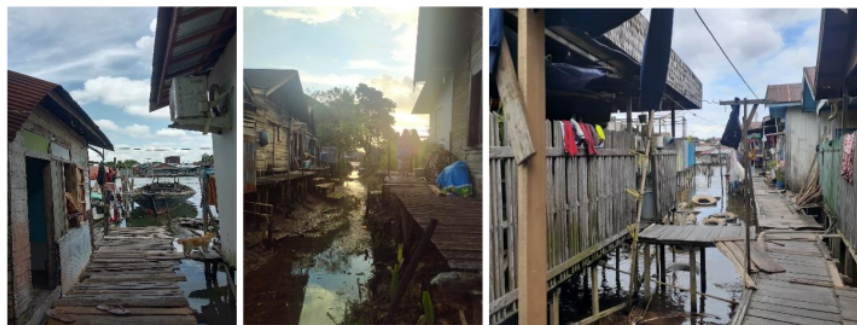
Gambar 2. Kondisi Fisik Permukiman Masyarakat Hilir Sungai Barito (Sumber: Dokumentasi Penelitian, 2021)
