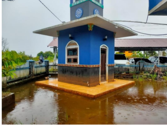
Gambar 3. Bangunan mushola yang tergenang di Desa Bangkit Baru
